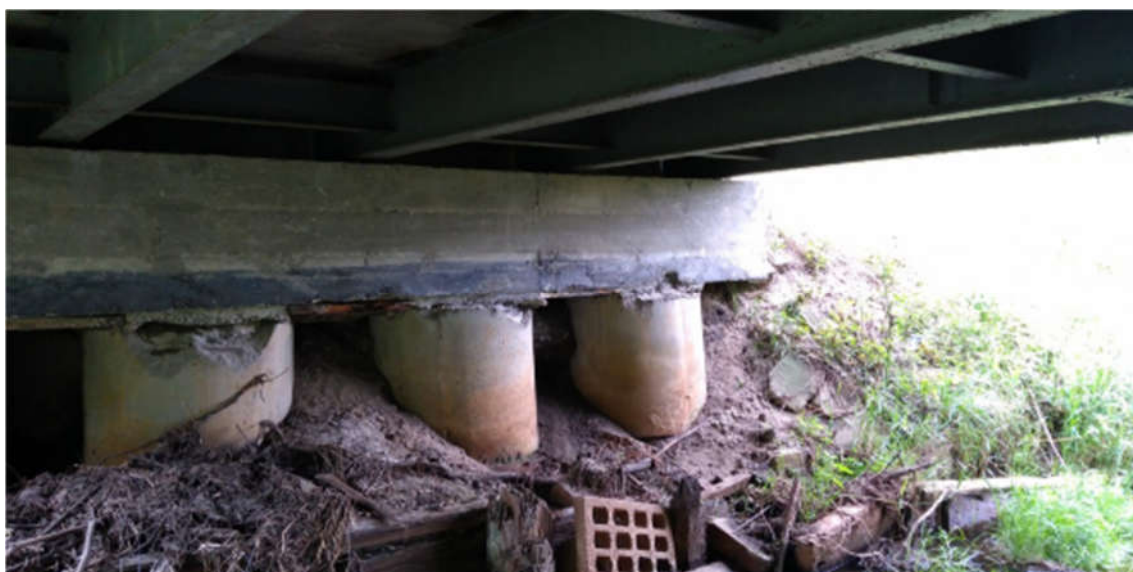
Jak wyżej – degradacja studni fundamentowych
