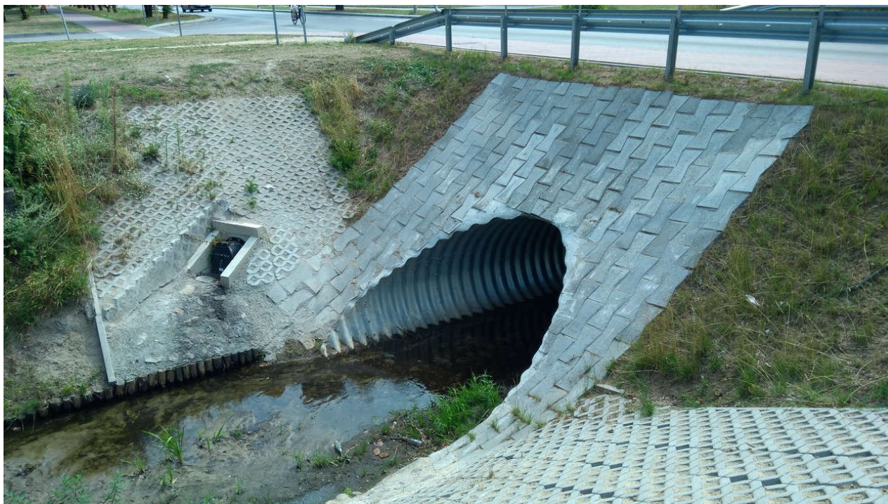
Przykład wykończenia wlotu i wylotu przepustu wielkogabarytowego
