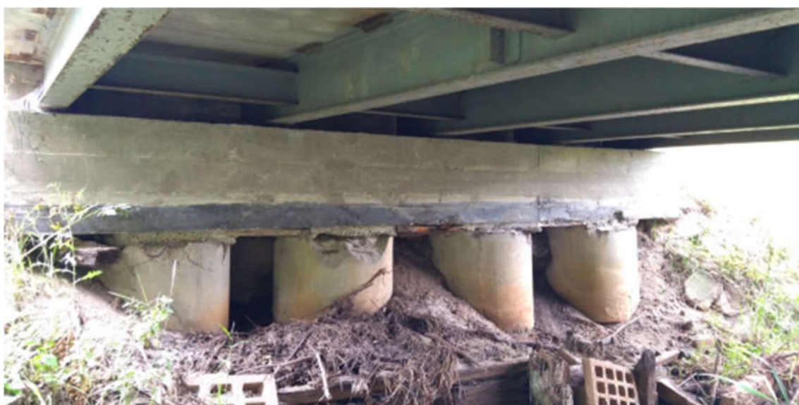
Posadowienie mostu na studniach betonowych
